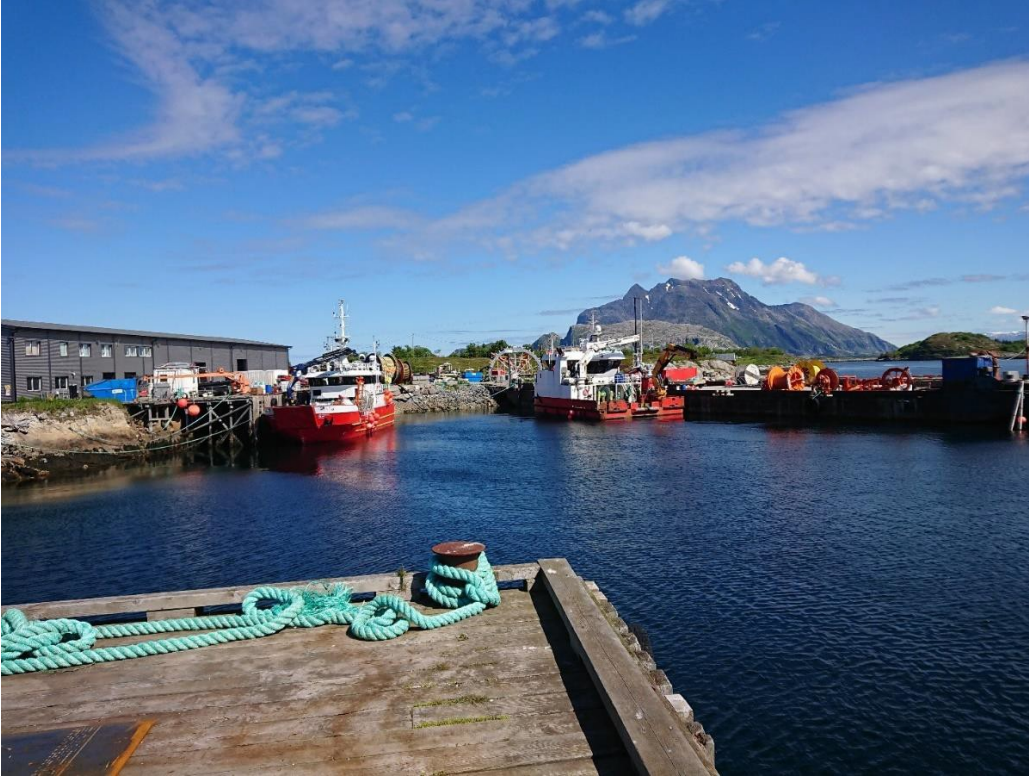
Figur 5. Sørøstsiden av planområdet mot kaiområder og lekter. Foto: Norconsult.
