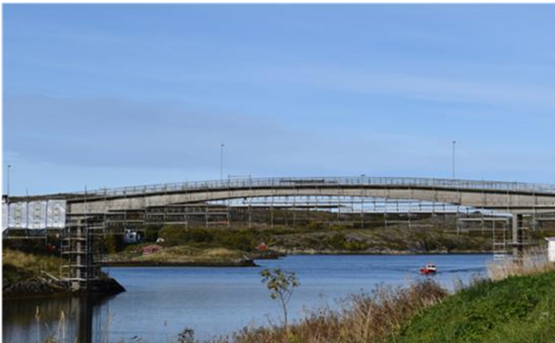
Gamle Herøysundet bru under vedlikehold sommeren 2020
