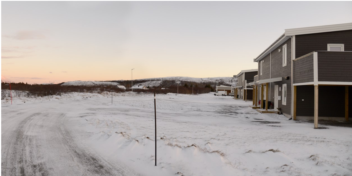
Foto 3: Bildet viser deler av samleveggen inn til Iberneset boligfelt og til høyre i bildet ses noen av tomannsboligene.
